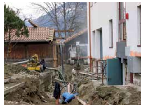
Bauabschnitt Dorfzentrum Plaus
